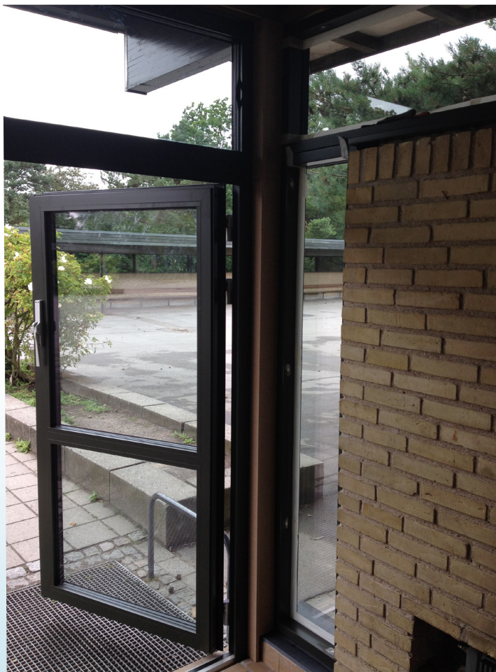
Gamle inddækninger blev skiftet, da der var PCB i alle fugerne.
