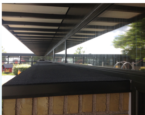
Gamle enkeltlagsglas blev skiftet til nye 3-lags energiglas.
