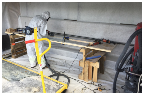
Gamle inddækninger blev skiftet, da der var PCB i alle fugerne.
