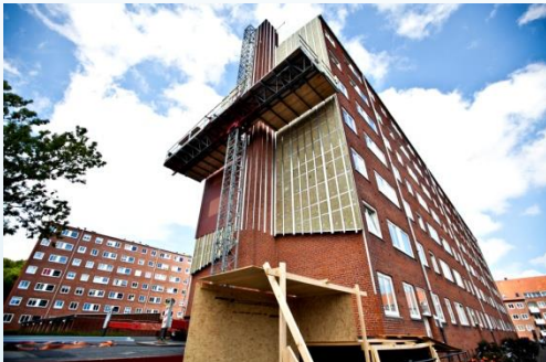
Platformen i arbejde
